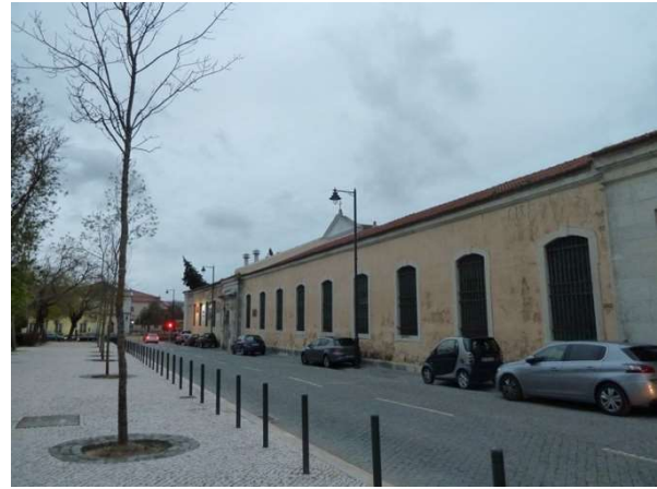
fig.29: Fachada actual do convento, que faz parte das instalações do Colégio Militar
