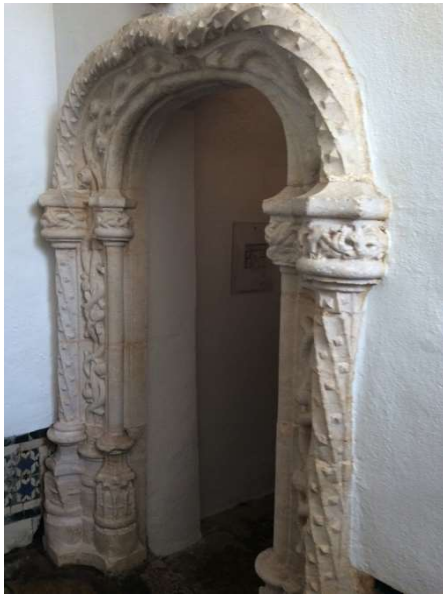
fig. 32: Portal manuelino no acesso interior à fonte
